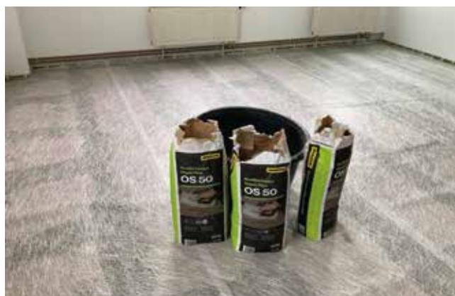
Um etwaige Rissübertragung aus dem Untergrund zu vermeiden, wurde auf der Fläche **Verstärkungsmatte GL** lose ausgelegt und im Anschluss mit selbstverlaufender Nivelliermasse **OS 50** gespachtelt und entlüftet.
