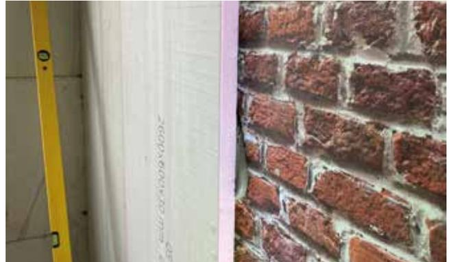
Austrotherm UNIPLATTEN® eignen sich z. B. in Innenräumen zum Verkleiden von Wandflächen und stellen gleichzeitig den Träger für weitere Gestaltungen dar. Nachdem der Untergrund, hier eine Mauerwerkswand, haftungsfreundlich vorbereitet ist, wird die Fläche mit Tiefengrund **LF 1** vorgrundiert. Anschließend werden die Platten z. B. mit Flex Klebemörtel **KGF 65** im Batzenverfahren angesetzt.
