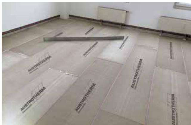
Die Aufnahme einer Platte zeigte, dass die Anhaftung des Klebstoffs am Blech und an der Unterseite der UNIPLATTE® ausreichte. Die Kontrolle der Arbeiten mit dem Richtscheit zeigte planebenheit. Der so vorbereitete Boden war bereit für den nächsten Arbeitsgang.
