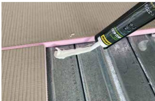
Die leicht zu bearbeitenden UNIPLATTEN® wurden im Versatz verlegt. Kreuzfugen wurden vermieden. Die Anhaftung der Unterseite in die Klebstoffraupen erfolgte mittels leichtem Einschieben.
