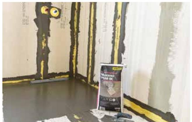
Austrotherm UNIPLATTEN® können z. B. als Trennwand- und Trägerelemente in Nass- und Feuchträumen verwendet werden (siehe Abdichtungsvarianten).
