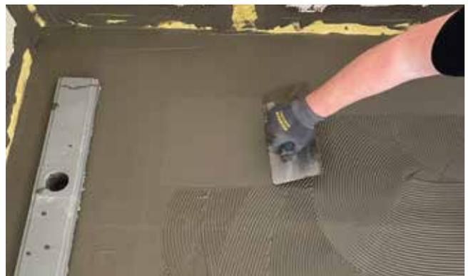
Nachdem die Eckbänder im Bodenbereich installiert sind, erfolgt die Eindichtung der Rinnenmanschette. Diese ist sorgfältig in die Dichtungsschlämme einzubetten. Gleichzeitig sind die vertikalen Dichtbänder zu installieren. Diese werden ebenfalls in die Dichtungsschlämme eingebettet und es ist darauf zu achten, dass der seitliche Gewebeanschluss vollständig geschlossen ist.
