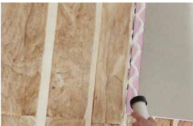
Austrotherm UNIPLATTE® kann sowohl auf Metallständer- und Holzständerkonstruktionen installiert werden. Zunächst wird die Platte mit **X-Bond MS-K 88 Express** am Rahmen geklebt und danach mit entsprechenden Schrauben zusätzlich befestigt.
