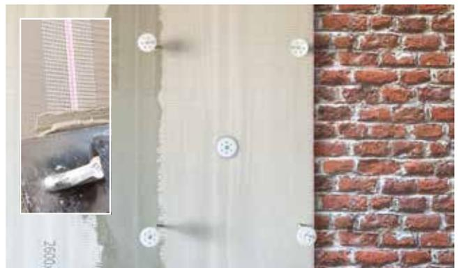
Nachdem die angesetzten Platten lot- und fluchtrecht ausgerichtet sind, die Kleberbatzen getrocknet und die Stoßfugen mit Glasfaserwebstoff **GS 10** verspachtelt sind, werden die installierten Platten zusätzlich verdübelt. Wir empfehlen 5 Dübel auf den lfdm-Plattenbreite.
