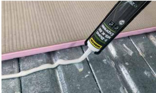
Dämmung einer Zwischendecke aus Trapezblech. Unter Berücksichtigung des Gesamtbodenaufbaus war eine Verklebung der UNIPLATTEN®, welche schon ab einer Dicke von 30 mm Dicke gute Dämmwerte erreicht, vorgegeben. Als formstabiler und schnellreaktiver Klebstoff aus der Kartusche wurde **X-Bond MS-K 88 Express** verwendet. Der Auftrag erfolgte raupenförmig.
