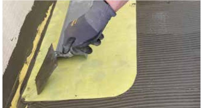
Eine bodengleiche Dusche mit Ablaufrinne soll eingefliest werden. Als Untergrund sind UNIPLATTEN® an Wand und Boden installiert. Die Beanspruchung durch Spritzwasser ist hoch und die Wassereinwirkung ist nach W2-I vorgegeben. Die Abdichtung der Stoßfugen erfolgt mit Dichtbandsystem **DB 100** und der Dichtungsschlämme Profi Dichtfolie Schnell Maximo **PSM 1K** (CM). Alles beginnt mit einer Ecke...
