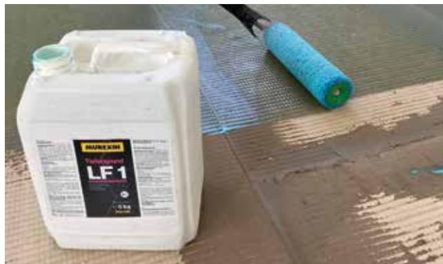
UNIPLATTEN® als Dämmung auf einer Zwischendecke (siehe auch Seite 7). Um Unebenheiten für den Oberbelag weitestgehend auszuschließen war die Dämmschicht zusätzlich mittels faserarmiertem Nivellement zu egalisieren. Zunächst wurde der selbstklebende Randdämmstreifen **RS 50** installiert und die Stoßfugen der UNIPLATTEN® mit Dicht- und Klebemörtel **DKM 95** zugezogen. Der Flächenvorstrich erfolgte mit Tiefengrund **LF 1**.
