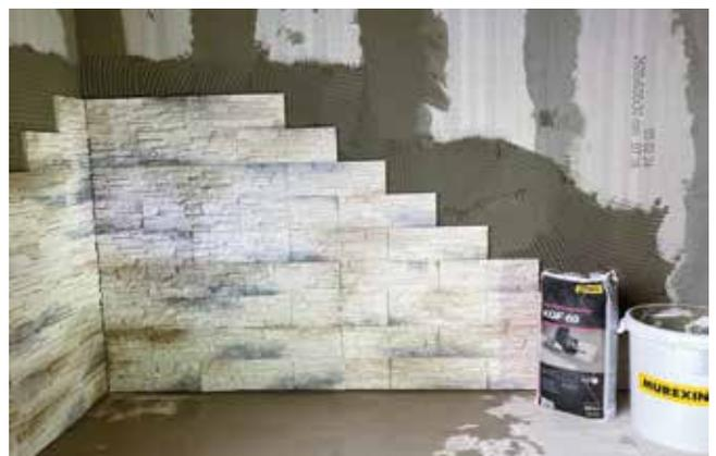
Ist die Plattenware fest und stabil installiert, können die Gestaltungsarbeiten beginnen, z. B. mit Flex Klebemörtel Grau **KGF 65** als Flächenegalisierung und Vorbereitung für weitere Malerarbeiten oder die direkte Verlegung von Keramik, Naturstein und/oder ähnlichen Elementen. Für fast alle Arten der Oberflächengestaltung hält Murexin entsprechende Verarbeitungsprodukte bereit.
