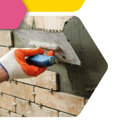
WDVS mit keramischen Belägen können auf massiven Wandbildnern im Neubau oder auf der thermischen Sanierung von Bestandsbauten angewendet werden. Auf Grundlage dieser Technischen Information können Kleinflächen bis. maximal Geschoßhöhe und entsprechender Fugenplanung ausgeführt werden.
