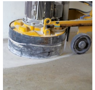
Vorbereiten durch Abschleifen des Untergrundes
