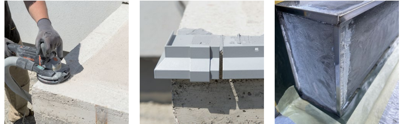
Mittels Handschleifgerät Vertiefung fräsen
